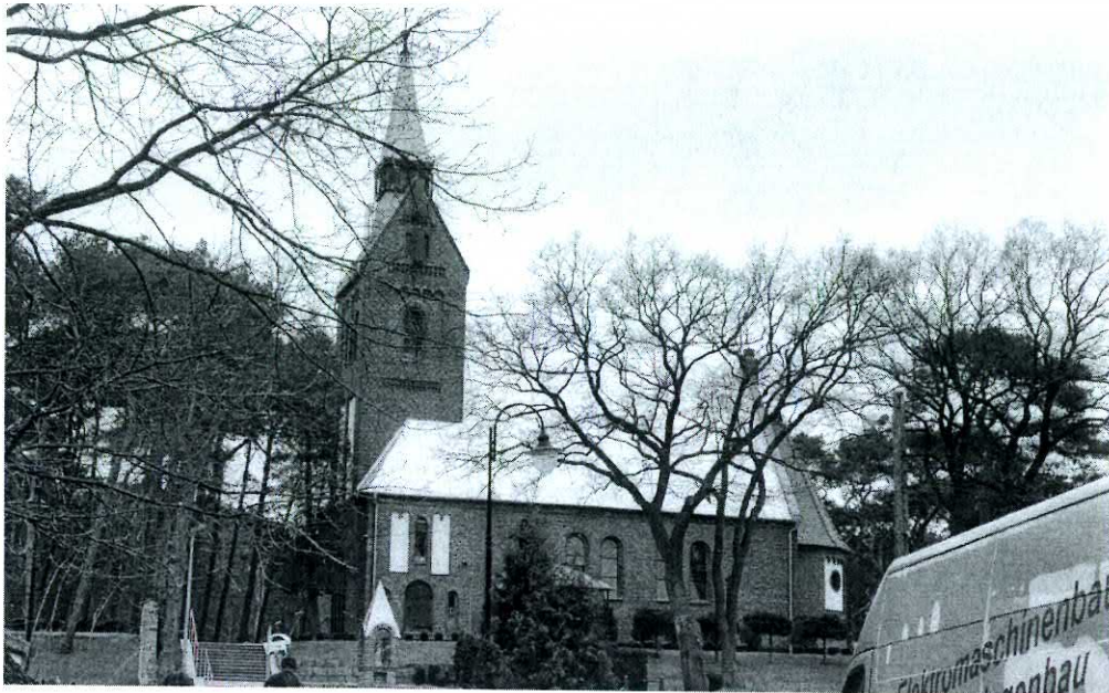
Zal. nr 1: Widok ogólny instalacji radiokomunikacyjnej.
