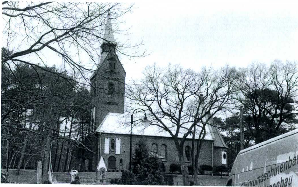
Zał. nr 1: Widok ogólny instalacji radiokomunikacyjnej.
