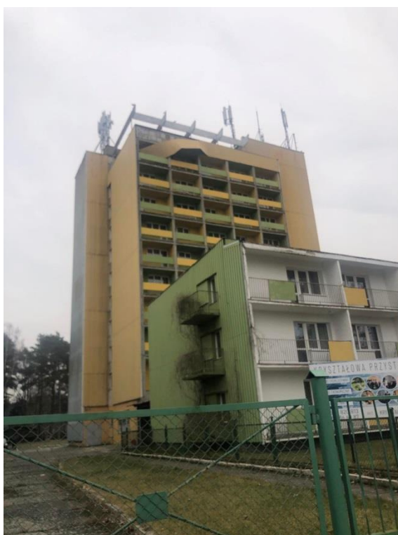
Zał. nr 1: Widok ogólny instalacji radiokomunikacyjnej.
