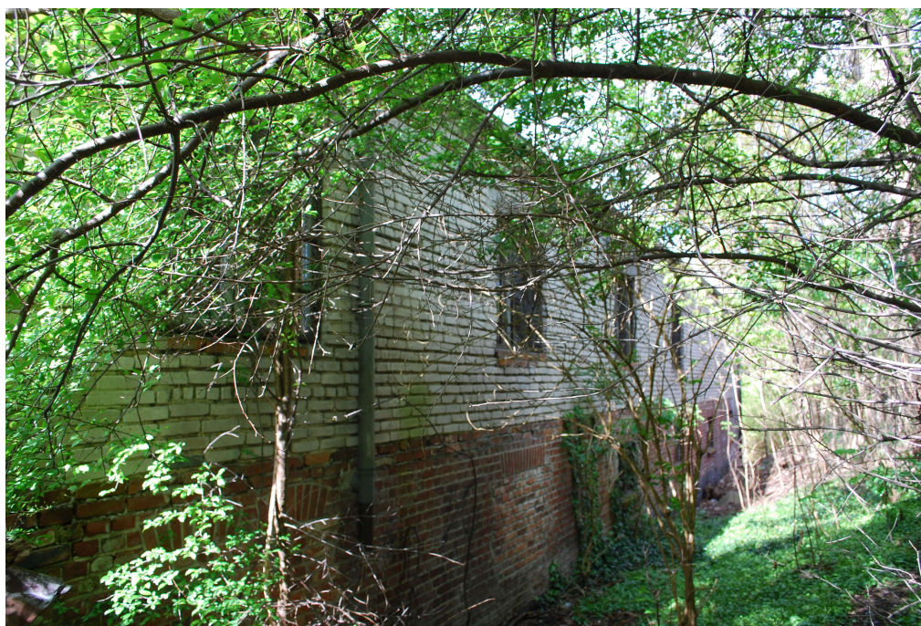
Trzebiatów, ul. Wojska Polskiego 36a ściana podłużna budynku przybudówki– elewacja północno-wschodnia
