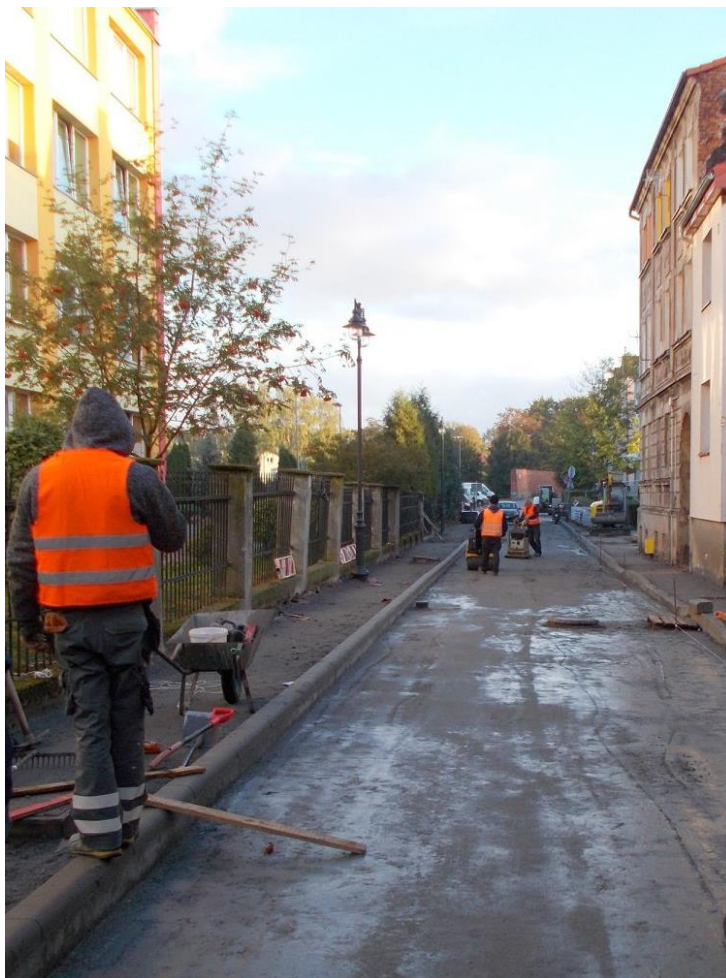
Inwestycja drogowa realizowana w powiecie gryfickim.
